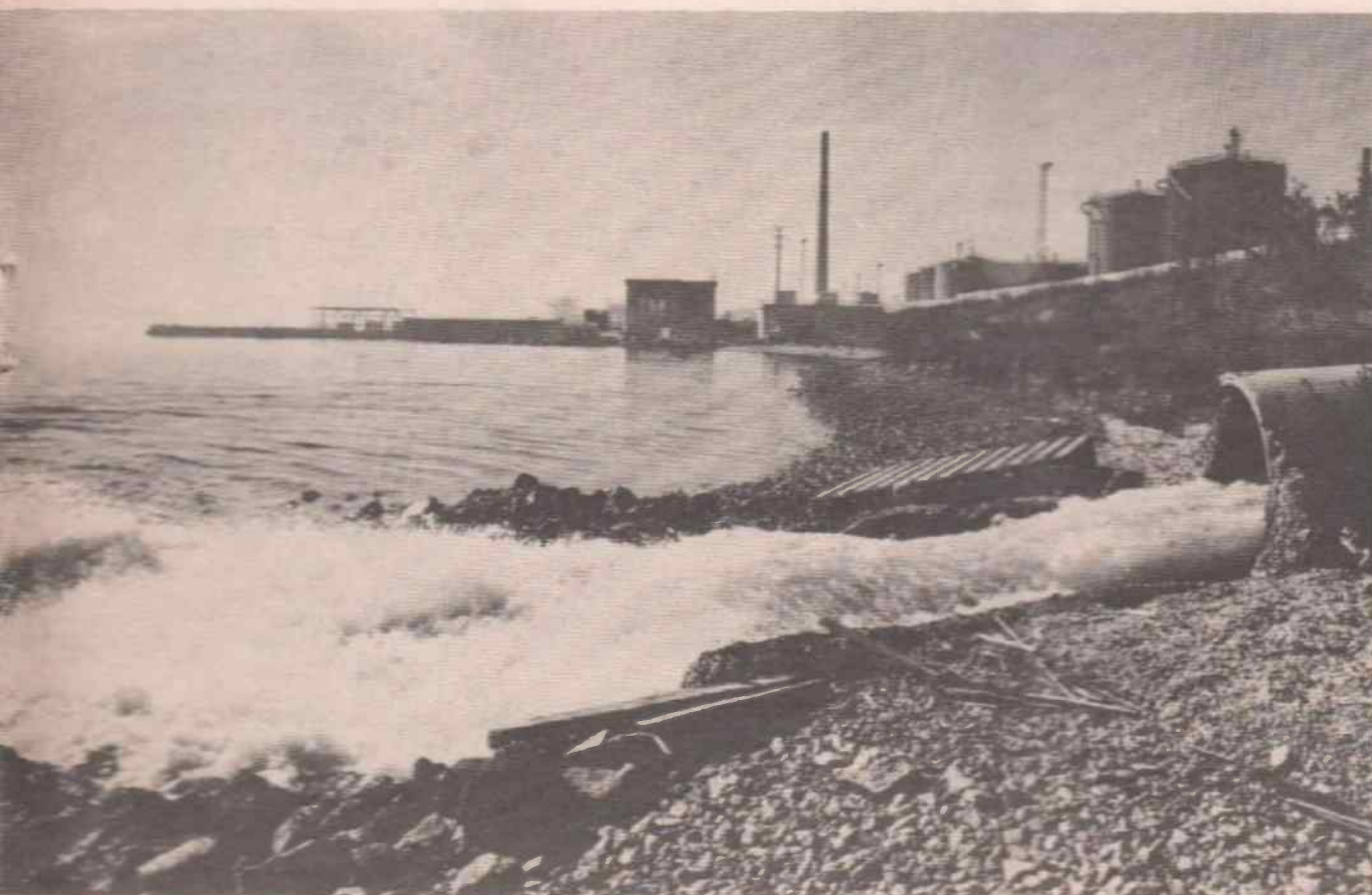
Déversoir de Shell dans l'étang de Berre.
