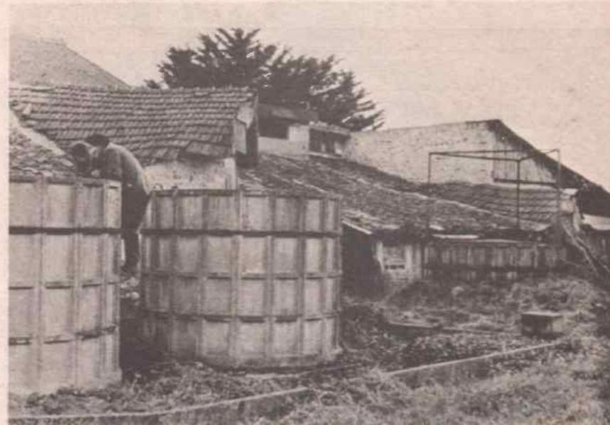
A gauche : les cuves que l'on remplit à tour de rôle de fumier. L'une fonctionnant et dégageant le gaz, l'autre en cours de remplissage.
