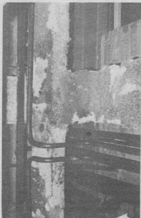
Jussieu : Les poutrelles sous les faux plafonds.
