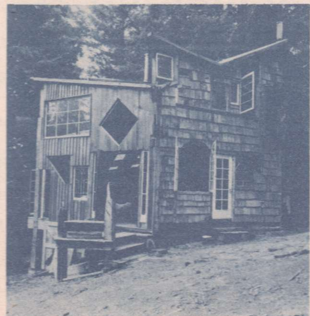
Maison en « shingles » (photo Barry Shapiro, Berkeley). La maison est réalisée suivant la technique des collages des peintres des années 20. Elle est faite d'un assemblage harmonieux d'éléments de constructions, tous récupérés sur les chantiers de démolition.
