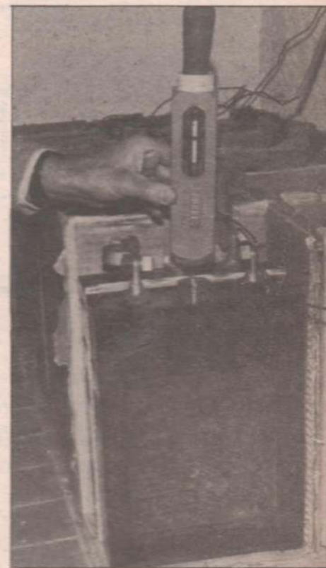
Vue du boîtier de commande, avec arrivée du câble venant des photopiles (en haut et à droite) et interrupteur central. Installation électrique tout à fait classique réalisée par l'électricien de Collioure, M. Mensier. Branchements effectués par un ingénieur folklorique...
