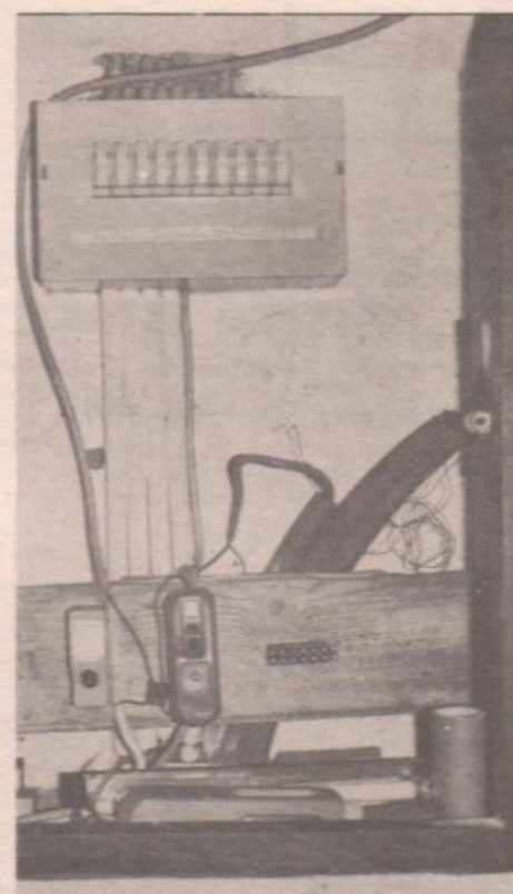
Vue du boîtier de commande, avec arrivée du câble venant des photopiles (en haut et à droite) et interrupteur central. Installation électrique tout à fait classique réalisée par l'électricien de Collioure, M. Mensier. Branchements effectués par un ingénieur folklorique...
