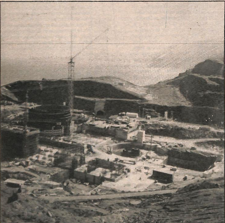
Le chantier de Lemniz, en cours de travaux.
