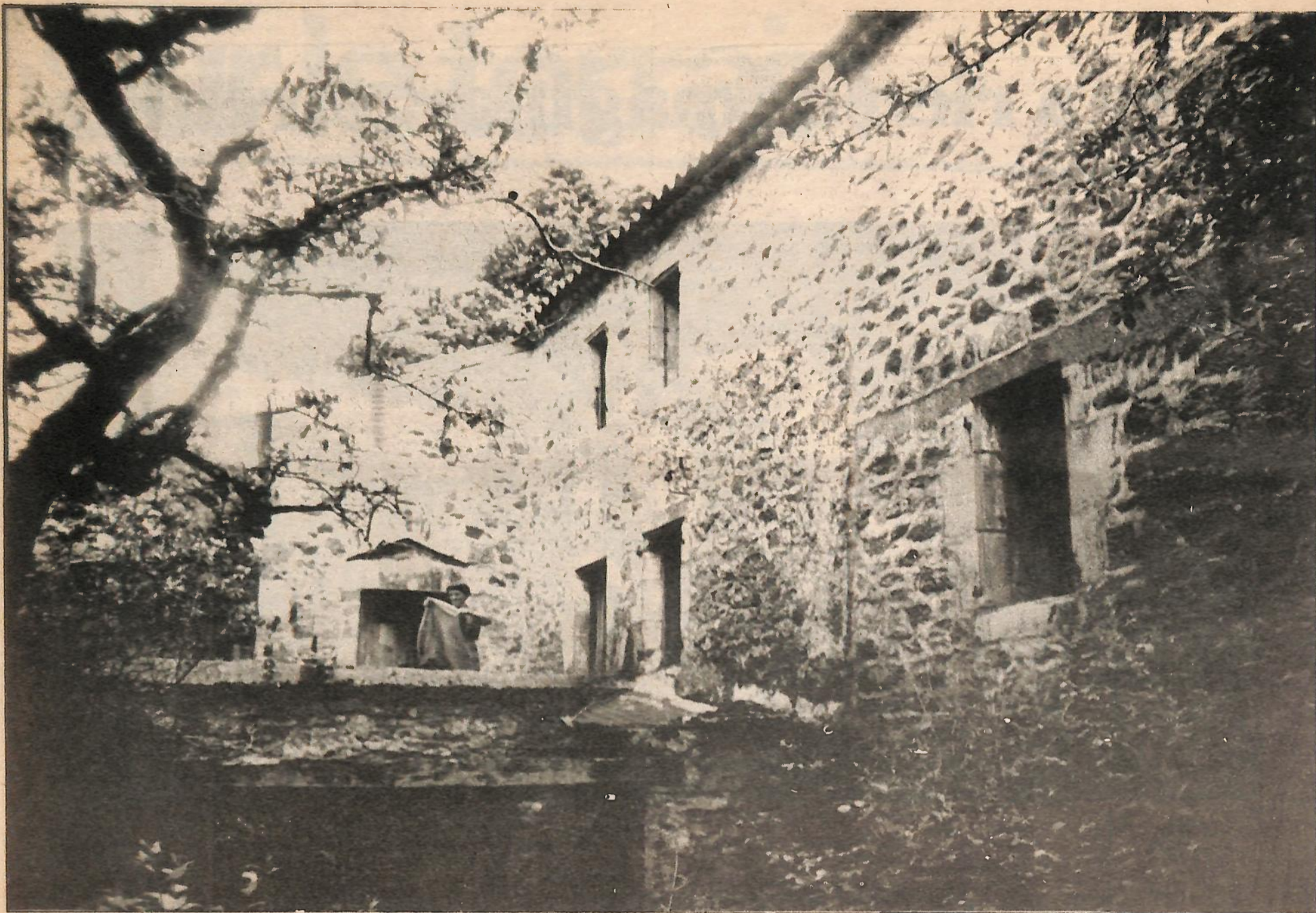
Les bâtiments du moulin
