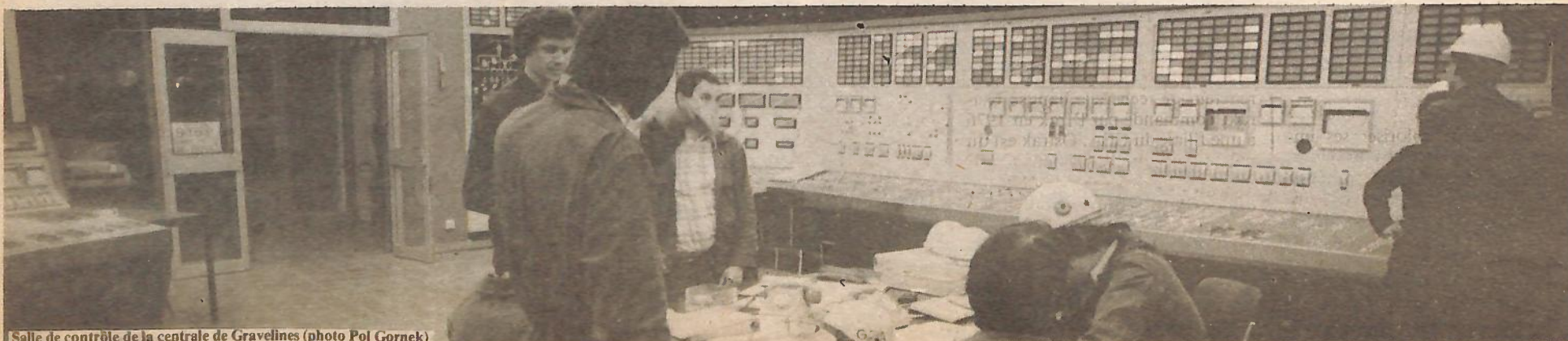
Salle de contrôle de la centrale de Gravelines (photo Pol Gornek)
